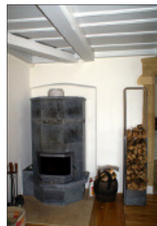
La chaudière à gaz vient en appoint du fourneau à pierre ollaire, dont le poids est de deux tonnes.
