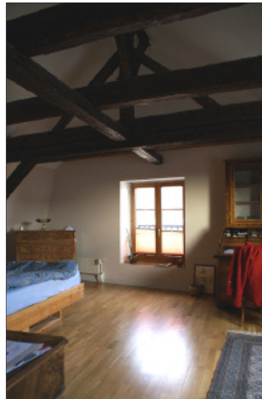
La poutraison d'origine de la charpente a été conservée.
