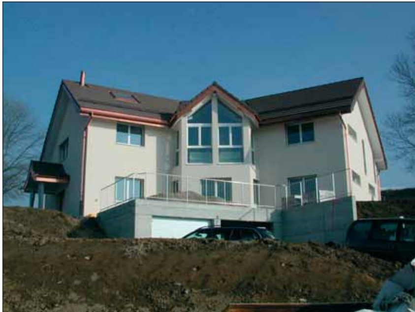
Bild 1. Das Einfamilienhaus in Puidoux mit hoher Energieeffizienz dank KNX
